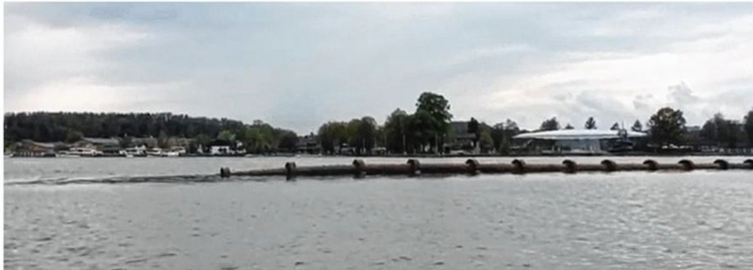
Das riesige Unterwasserrohr des Chiemsee-Ringkanals trieb im Mai 2017 vor Prien vom Grund des Chiemsees bis an die Oberfläche. In diesem Frühjahr sollen die Rohre zwischen Felden und Stock mit 180 zusätzlichen 390-Kilo-Gewichten beschwert werden, damit das nicht noch einmal passiert.
